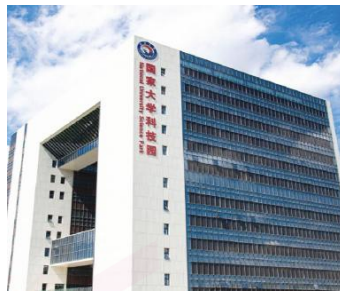
国家大学科技园幕墙工程, 西宁, 青海 National University Science Park, Curtain Wall Project, Xining, Qinghai
